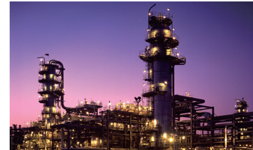
ガスプラント(サウジアラビア)
