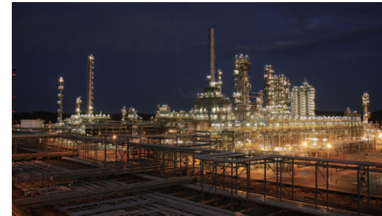
ガスプラント(サウジアラビア)
