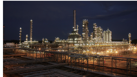
ガスプラント(サウジアラビア)
